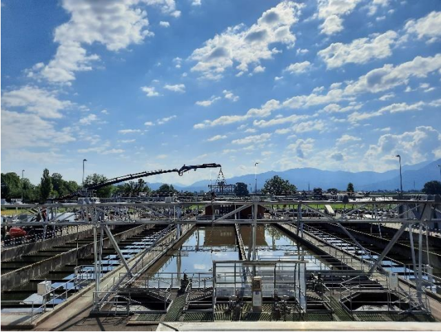
Montage Stahlbau, Tragwerke über den Becken der Vorklärung, Denitrifikation und Nachklärung
