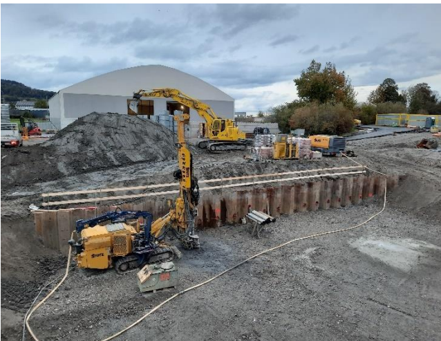
Rückverankerung der Spundwände
