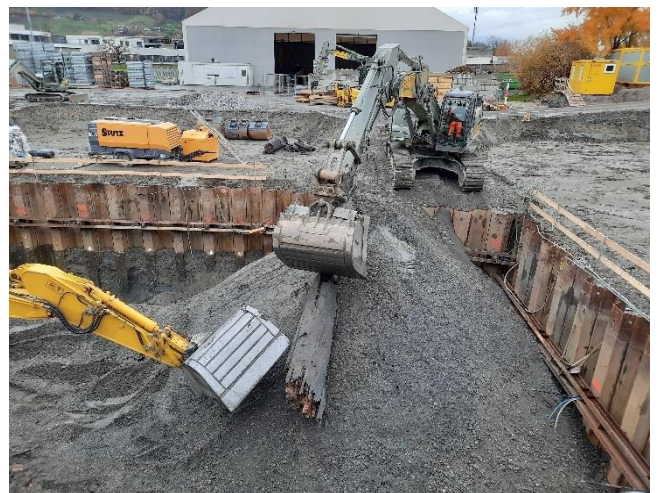
Bei Aushubarbeiten eine "uralte" Schotterreiche gefunden
