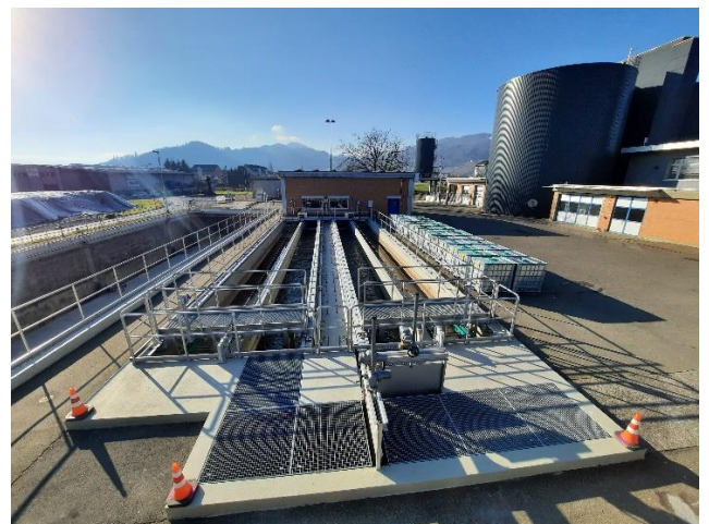
Neue, SUVA-konforme Geländer
