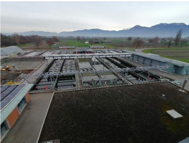
Faltdach eingefahren, keine Stromproduktion
