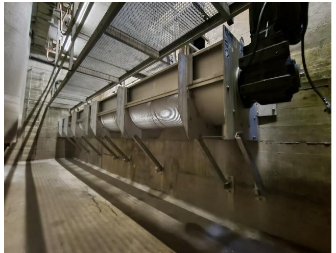
Einbau Siebrechen im Pumpensumpf des HWPW Neugrütt 2
