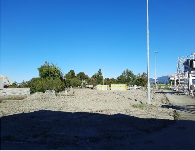
Abtrag Oberboden (Humus) und Unterboden
