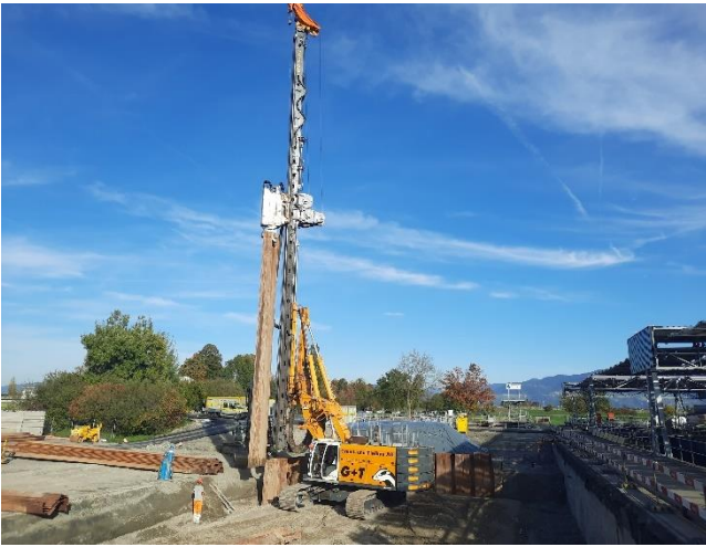
Einvibrieren von 15 m langen Spundwandprofilen zur Bildung einer dichten Baugrube
