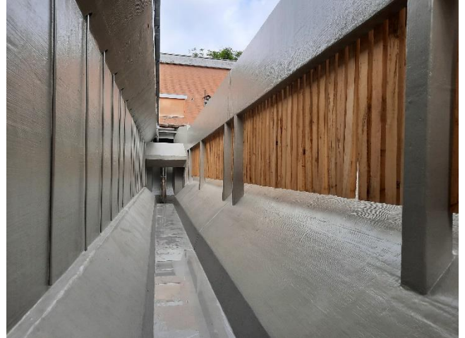
Neue Trennbalken aus Eiche zum Öl-/Fettfang
