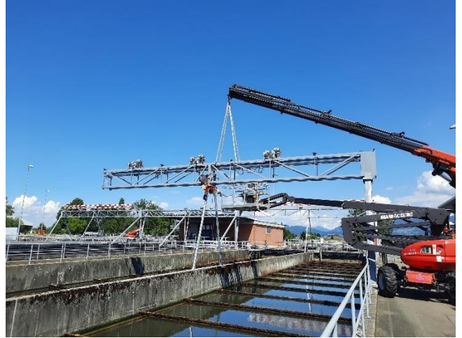
Montage Stahlbau, Tragwerke über den Becken der Vorklärung, Denitrifikation und Nachklärung
