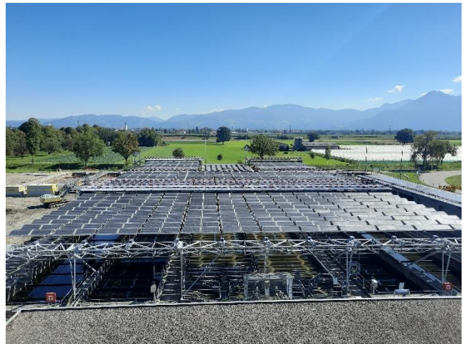
Faltdach ausgefahren, 1280 Module produzieren Strom
