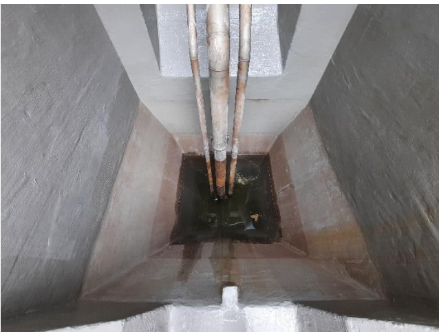
Betonsubstanz wurde beschichtet, neue Rohrleitungen Mammutpumpe
