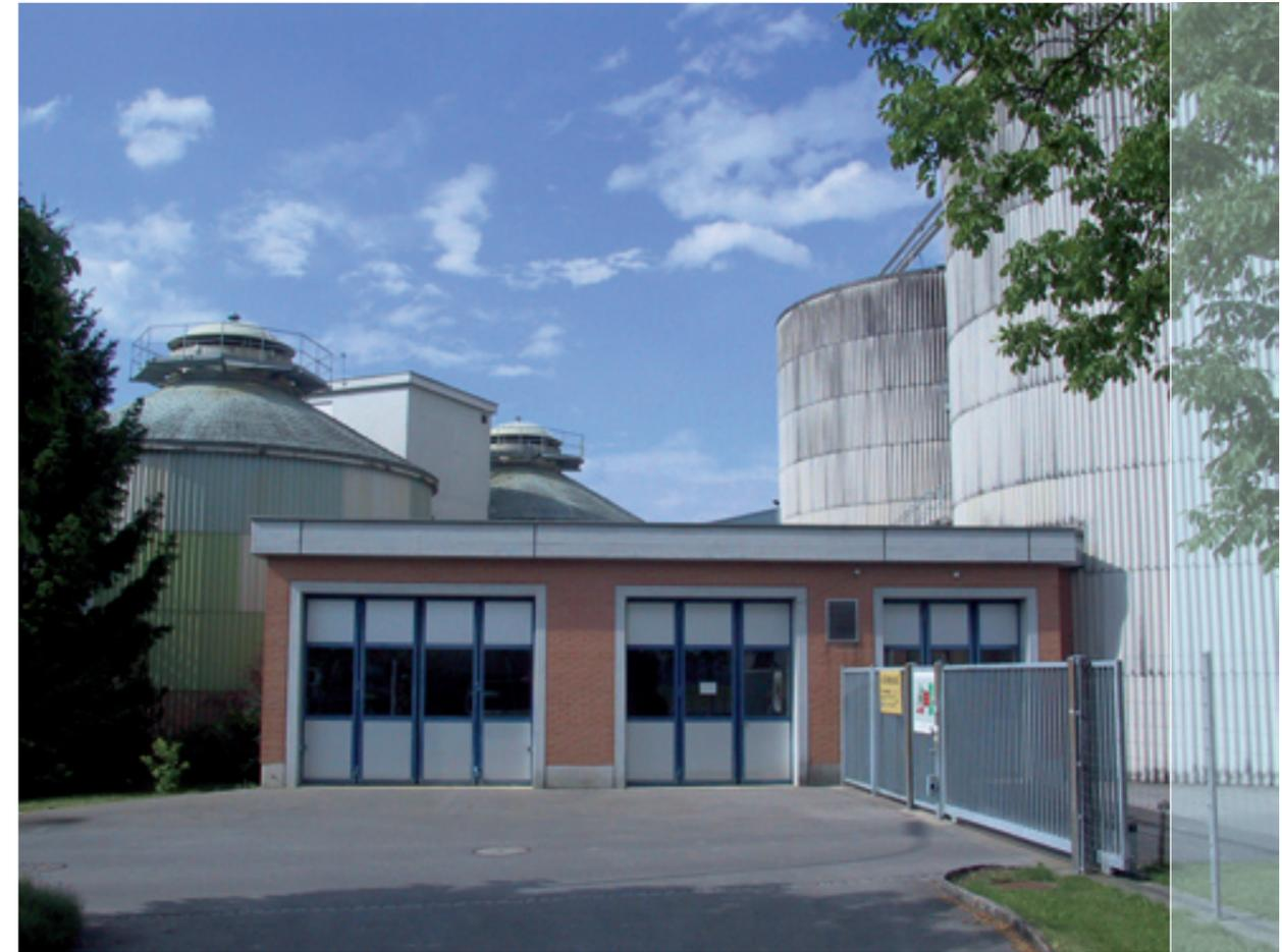
der eine oder andere Behälter beschickt werden kann. Dort dickt er durch Absinken ein, während das überstehende Faulwasser zur Trennung von Restfeststoffen dem Faulwasserabsetzbehälter zufließt. Hat einer der beiden Schlammstapelräume einen entsprechenden Füllstand erreicht, wird er in einen dritten Stapelbehälter entleert, welcher als Zwischenspeicher vor der Abgabe des Schlammes zur externen Weiterbehandlung dient.
