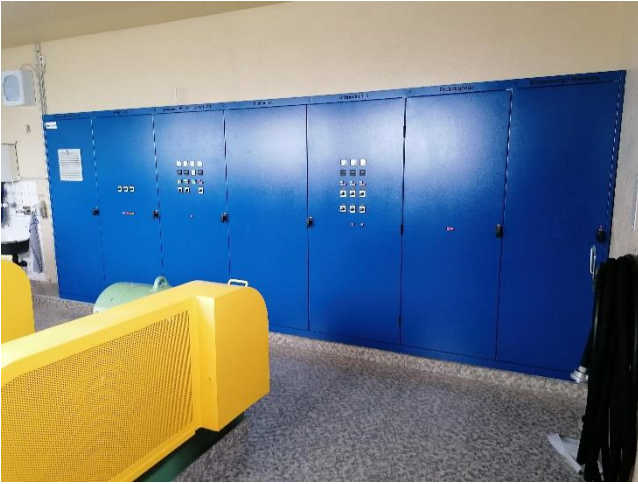
Ersatz Steuerschrank
