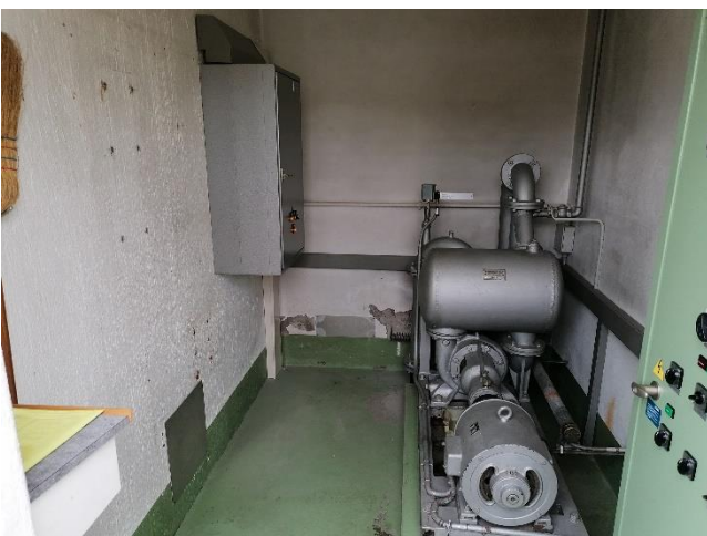
PW Neuwies, Umbau der Niveaumessung von Perlrohr auf auf Druckmessung
