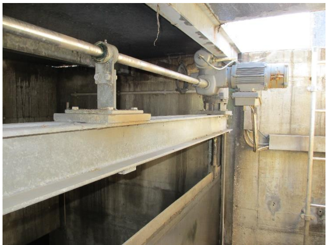
Ersatz Hochwasserentlastungsschieber
