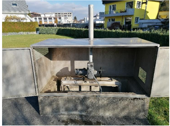
Austausch Entlastungsschieber
