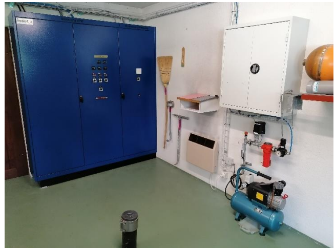
Ersatz Steuerschrank
