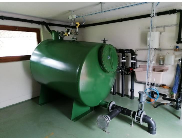
Anpassungen Vakuumtank
