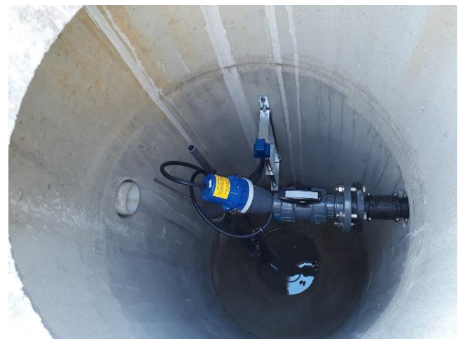
Inbetriebnahme neuer Schacht
