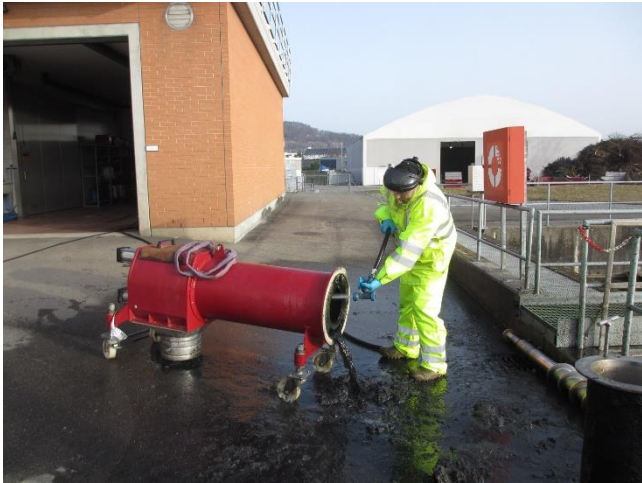
Reinigung Schlammverkrüstung
