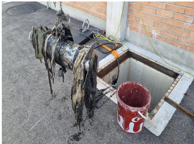
Reinigung „verzapftes“ Rührwerk
