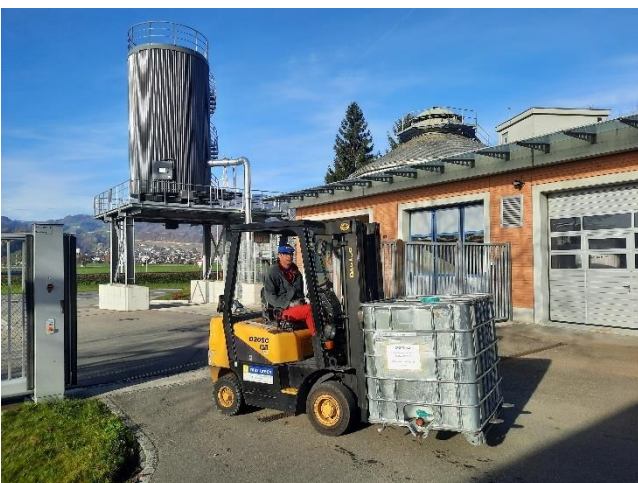
Entgegennahme Co-Substrat für den Faulturm
