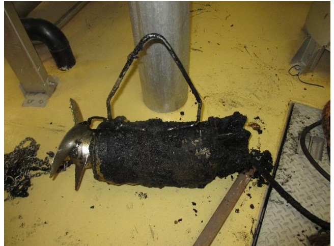
Rührwerke reinigen
