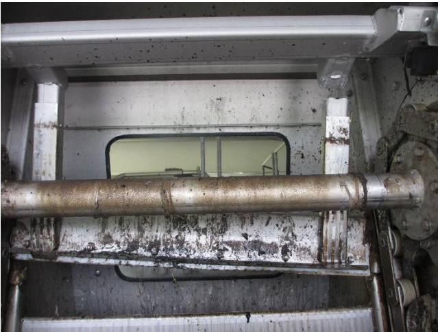
Abstreifer Rechen reparieren
