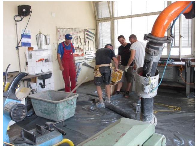
Betonierung der Trennwand über Öffnungen in der Werkstatt
