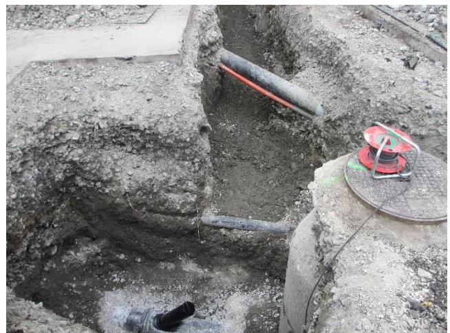
Tiefbauarbeiten für neue Anschlüsse an den Bunker
