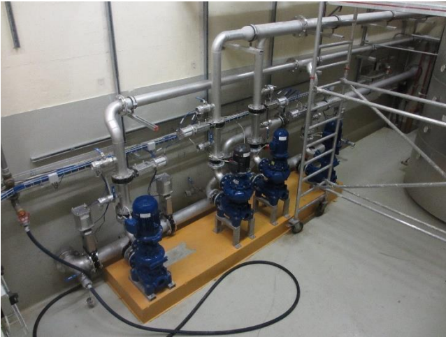
Neue Frisch- und Schwimmschlammumpen
