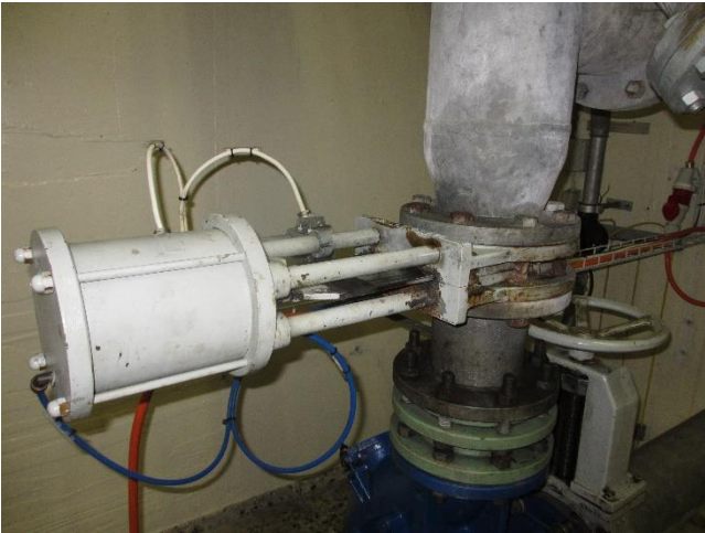
Schieber ersetzen
