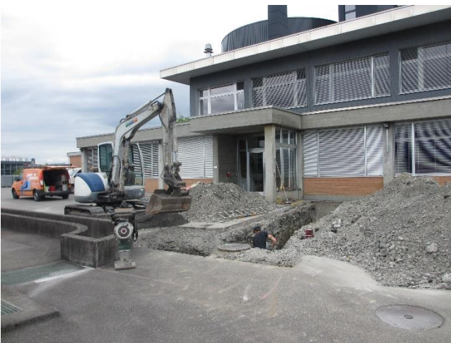
Tiefbauarbeiten für neue Anschlüsse an den Bunker
