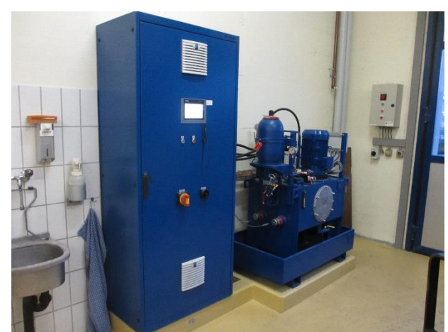
Hydraulikanlage für Silo
