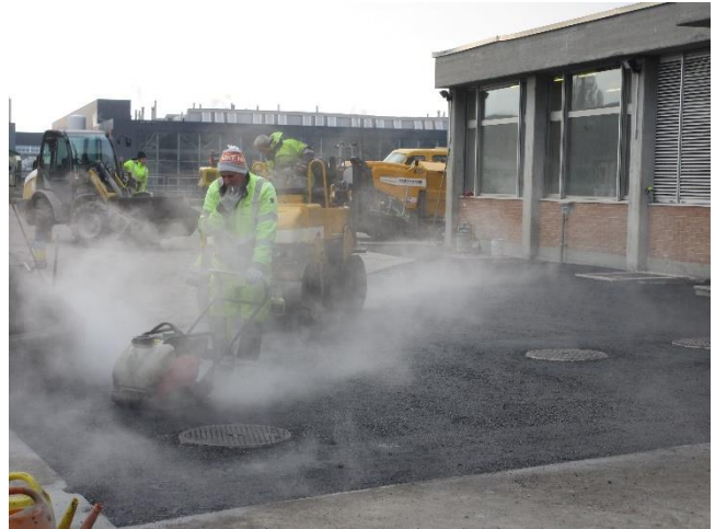
Neuer Belag Vorplatz Dienstgebäude
