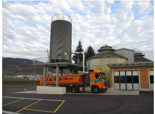
Verlad ab Silo in LKW-Muldenkipper
