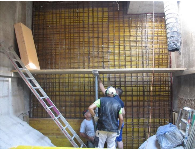
Schalung der Trennwand im Frischschlamm bunker
