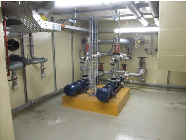
Beschickungspumpen Dekanter
