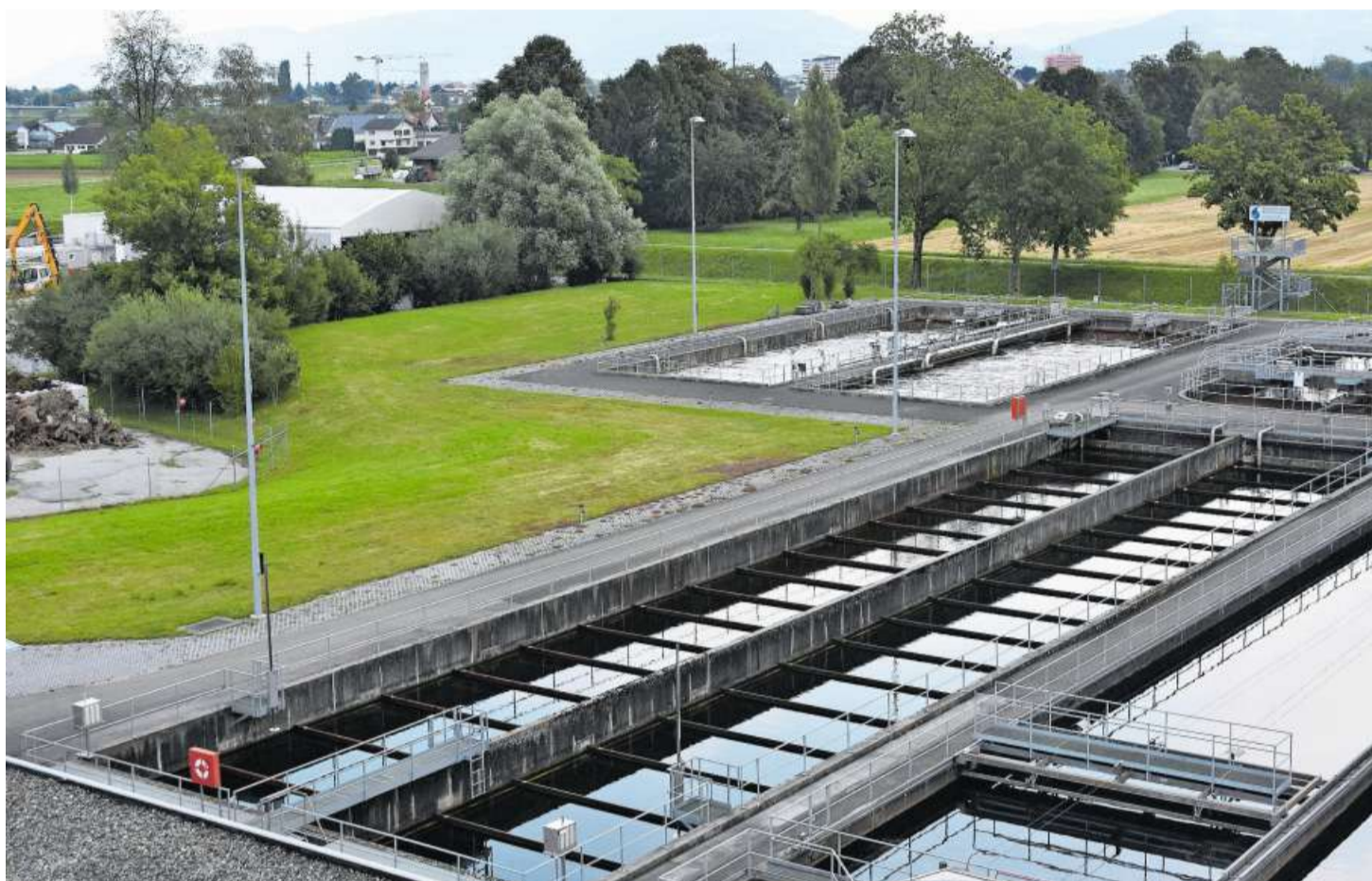
Links neben den vorderen Klärbecken ist das 37x21 Meter grosse Gebäude in der ARA Rosenbergsau geplant.
